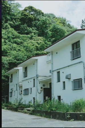
「THE Base APARTMENTS」
